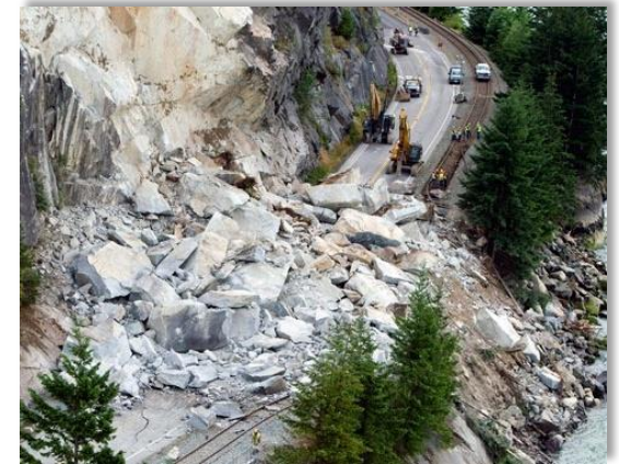
Ecroulement rocheux sur une autoroute, Canada, 2008
