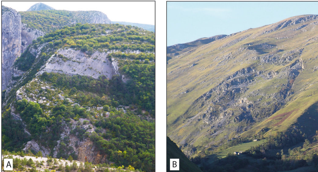
Figure 8 : Exemple de mouvements de grande ampleur. A : Glissement translationnel dans les gorges du Verdon (post-rupture paroxysmale ; l'escarpement dépasse les cents mètres de large). B : Glissement du Layens (Fabre et al., 2001) dans les Pyrénées (en cours d'évolution ; les maisons donnent l'échelle) (photos personnelles).
